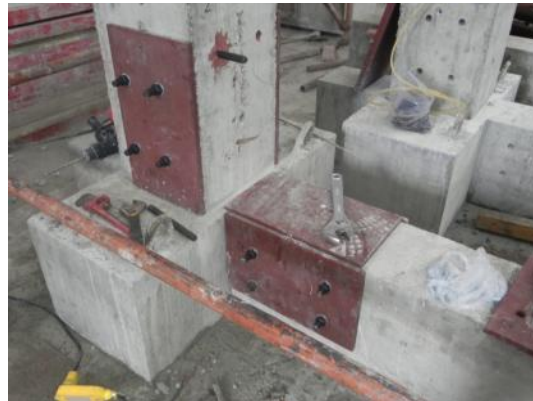
③ 安装钢板
