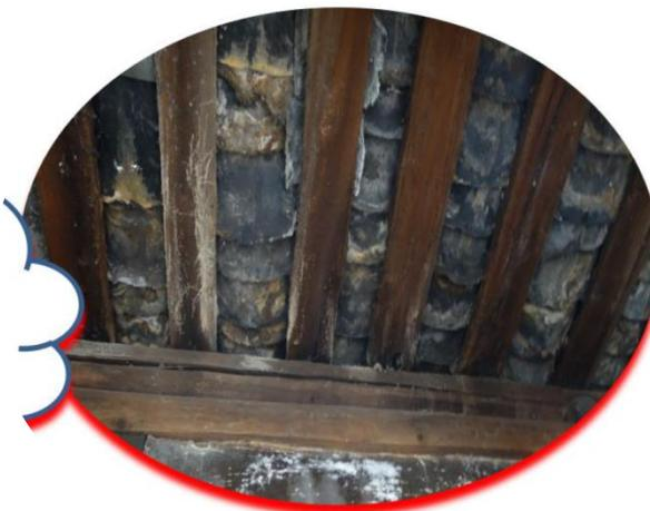
椽条出现腐朽、变形或断裂，以及部分屋面瓦出现滑瓦
