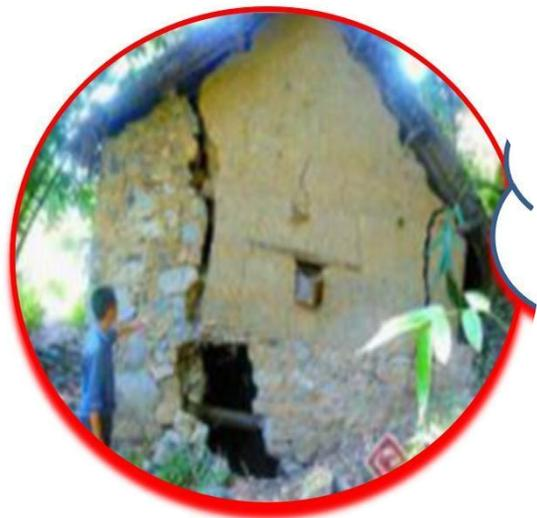
上部生土承重墙出现多条沉降裂缝，最大裂缝宽度**超过30mm**
