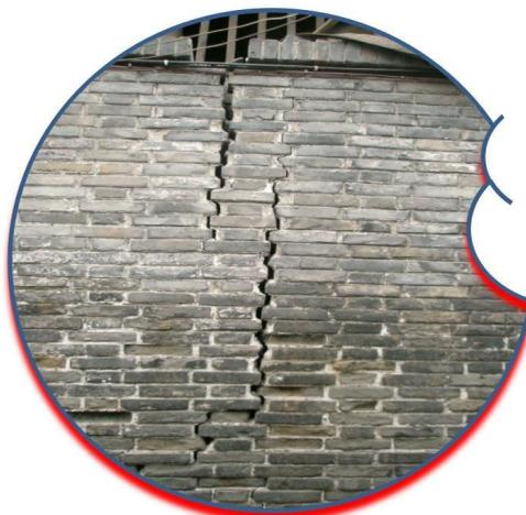
受压墙竖向裂缝宽度**大于2mm**、缝长**超过层高1/2**的裂缝，或产生**超过层高1/3**的多条竖向裂缝，受压柱产生宽度**大于2mm**的竖向裂缝
