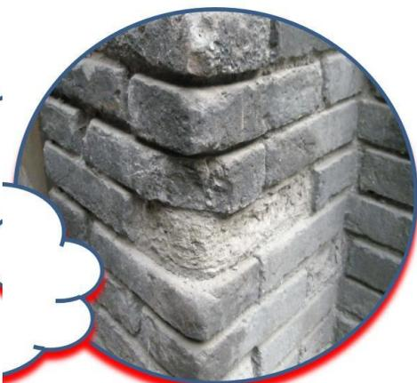
承重墙、柱表面风化、剥落，砂浆粉化，有效截面**削弱达1/4以上**
