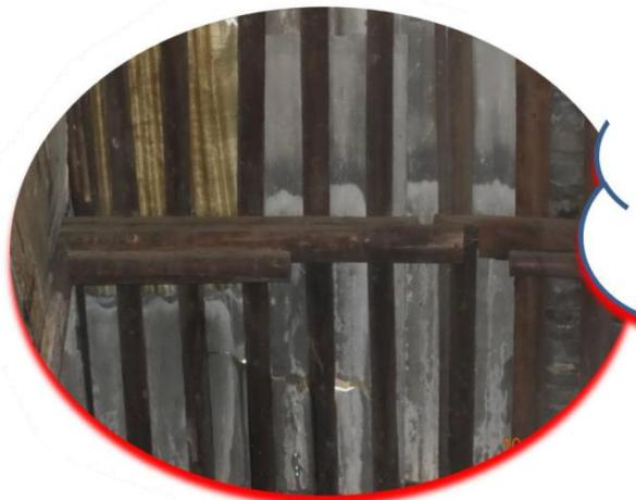
连接构造有严重缺陷，已导致节点松动、变形、滑移、沿剪切面开裂、剪坏和铁件严重锈蚀、松动致使连接失效等损坏
