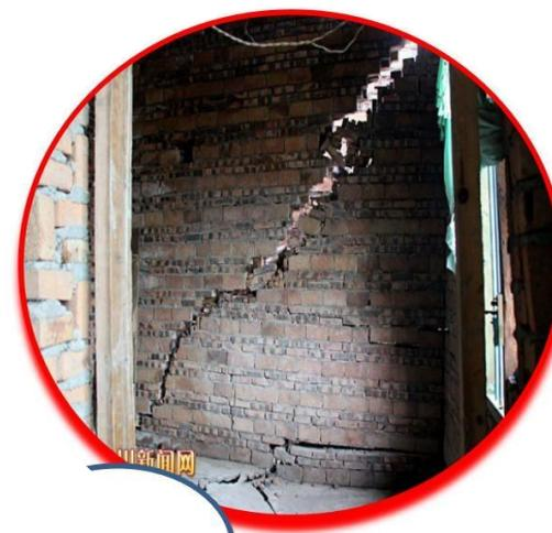
地基基础产生过大不均匀沉降，使上部墙体产生裂缝宽度**大于10mm**，且房屋倾斜率**大于1%**
