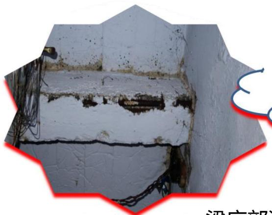
梁底部混凝土缺失，
