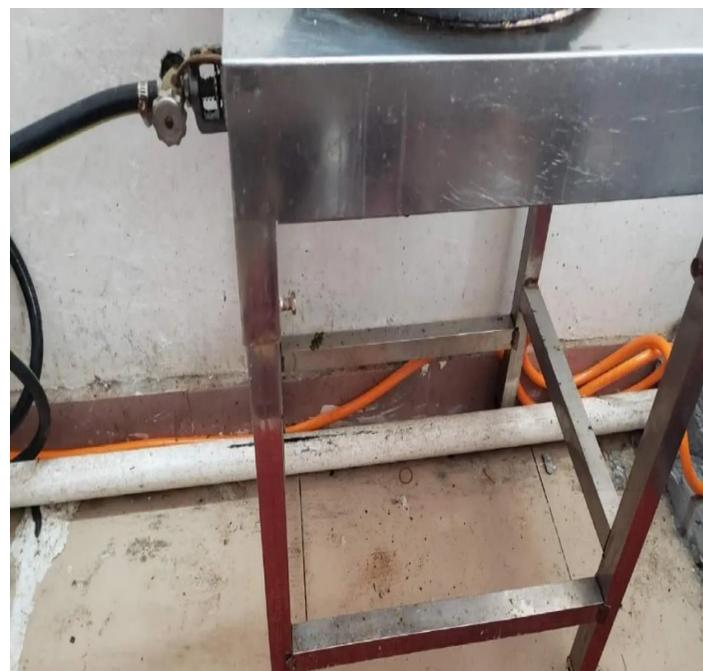
燃气管道软管长度超过2m
