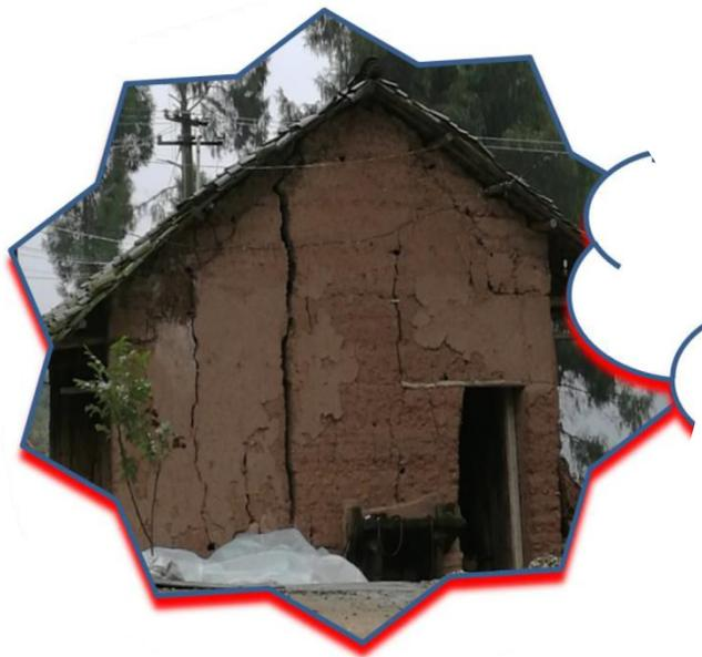
受压墙沿受力方向产生缝宽大于20mm、缝长超过层高1 / 2的竖向裂缝，或产生缝长超过层高1 / 3的多条竖向裂缝
