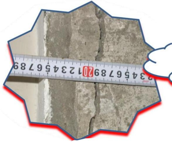
柱产生竖向裂缝，
