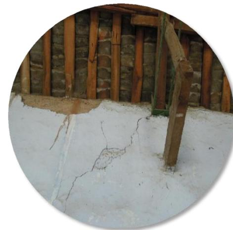
支承梁或屋架端部的墙体或柱截面因局部受压产生多条竖向裂缝或斜向裂缝，或最大裂缝宽度已**超过1mm**
